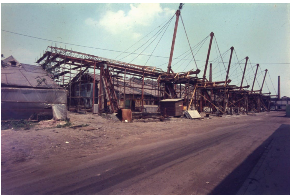
17. kép. December 4. Drótművek, Miskolc építése. Építész: Molnár Péter, statikus: Ivits Iván. Az új csarnok a meglévő felett épül. MIEA 21105_6_0030
