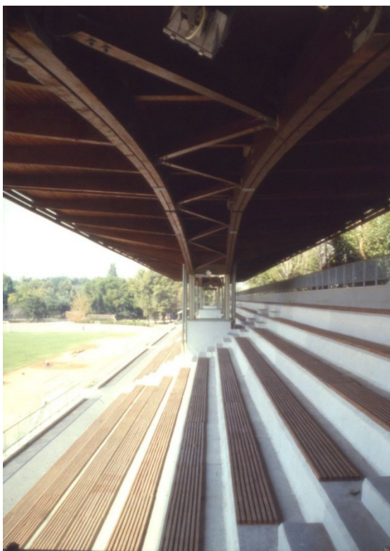
23. kép. Úttörőstadion. A szerkezet részlete. MIEA 22603_2_0003
