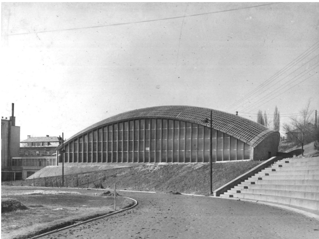
6. kép. Vasas Teniszcsarnok építése. Az elkészült csarnok külső képe. A hullámlemezekre rászertelt keresztirányú alumínium profilok a héj merevítésében játszanak fontos szerepet. MIEA 4136
