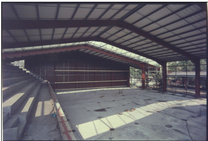
37. kép. Cegléd Sportcsarnok. Építés közbeni kép. Látható a CONDER tipizált könnyű-acélszerkezet építése. MIEA 22601_0005_0001
