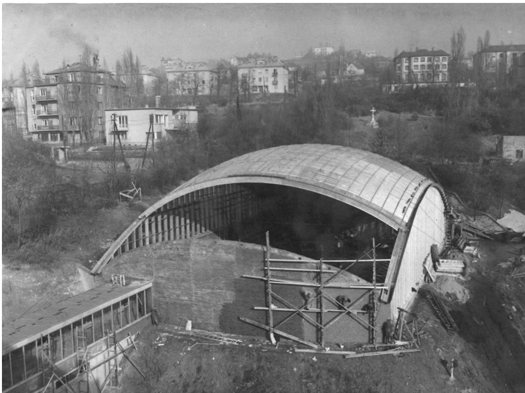
5. kép. Vasas Teniszcsarnok építése. A bontakozó lefedés. MIEA 4125
