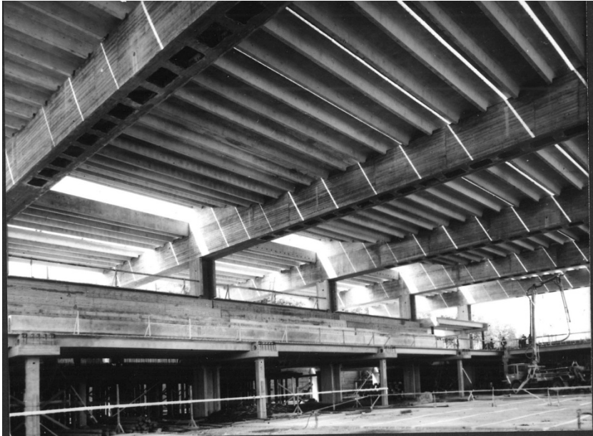
33. kép. Balaton Uszoda. Építés közben. A medenceteret keresztben áthidaló helyszínen előregyártott és beemelt főtartók között feszített TT tartók sorakoznak. MIEA 17520
