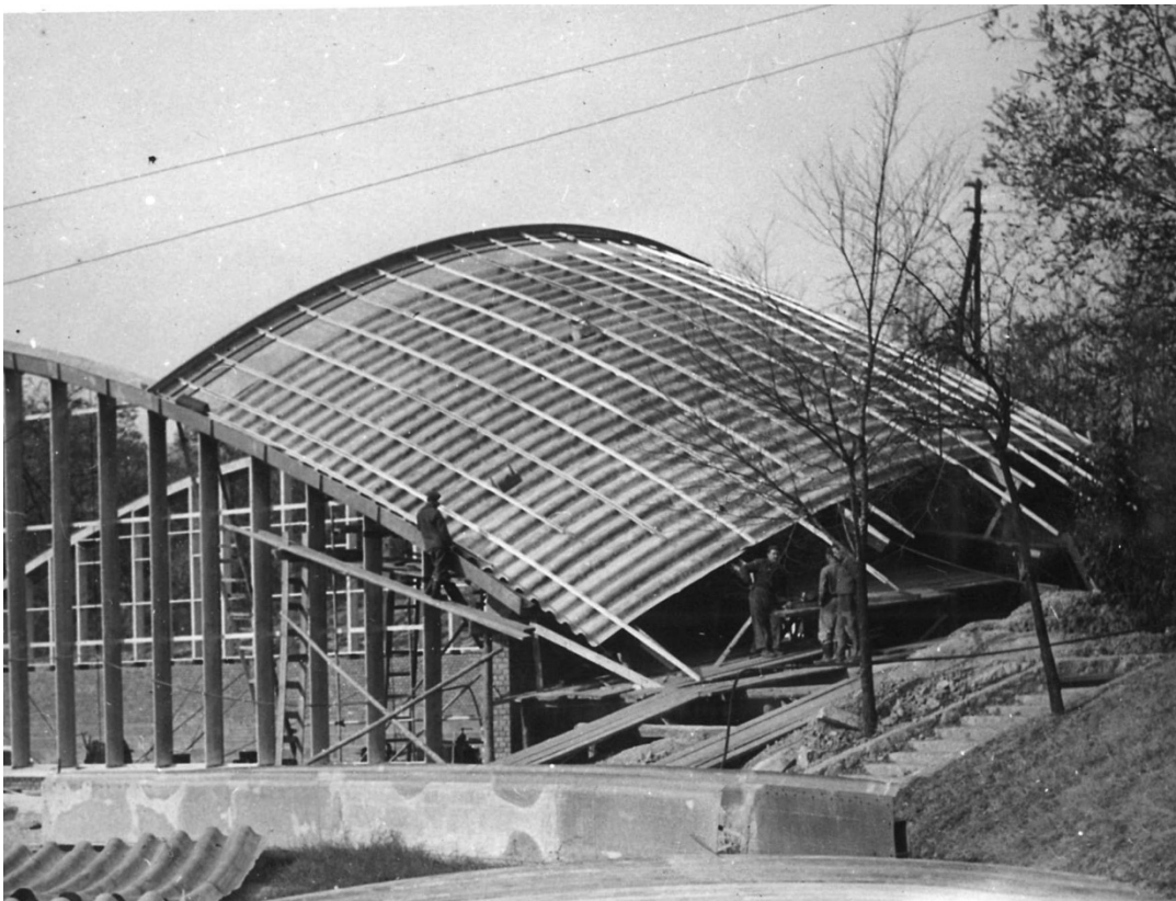
4. kép. Vasas Teniszcsarnok építése. Az egymáshoz kapcsolt alumínium szinuszhullámlemez sávokat (melyek az átlagosnál vastagabbak) az üvegfalak felső ívjére és a „kilövő” tartókra támaszkodva húzzák fel egyre magasabbra. MIEA 3937
