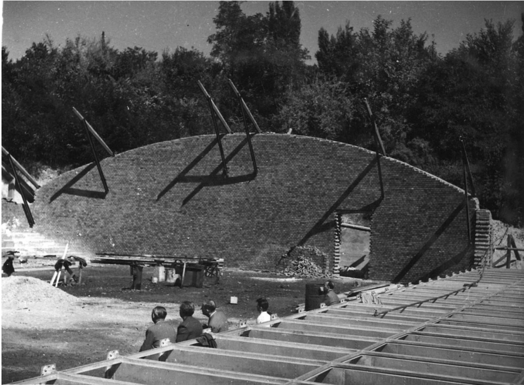
3. kép. Vasas Teniszcsarnok építése. A téglavégfalra rögzített „kilövő” tartók. Melyek majd vezetik a héjboltozat felhúzásának első szeleteit. MIEA 3931
